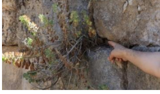
الشكل (٢): يوضح نمو الفطريات السوداء على الحر والمونة المستخدمة كملاط لربط الحجارة، قلعة حارم، حارم شمال غرب سورية (تصوير الباحث، ٢٠٢٤م).
